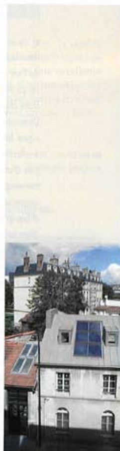
Façade Sud, sur rue, avant et après : architecture contextuelle préservée malgré la création de 2 lucarnes et la pose de 6 capteurs solaires Velux. Zinc prépatiné mat (VM Zinc) pour l'écologie et l'esprit toiture parisienne. © Paul Kozlowski
