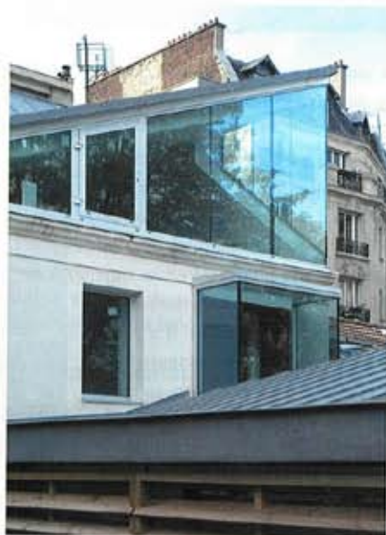
Vue sur la façade Nord au toit surélevé de 40 cm, avec un astucieux effet de plage. Châssis en mélèze pour protéger les baies vitrées du séjour à l'Est. © Paul Kozlowski
