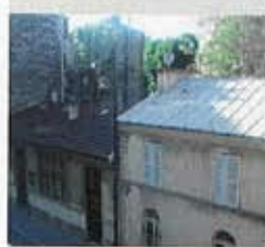
Façade Sud, sur rue, avant et après : architecture contextuelle préservée malgré la création de 2 lucarnes et la pose de 6 capteurs solaires Velux. Zinc prépatiné mat (VM Zinc) pour l'écologie et l'esprit toiture parisienne. © Paul Kozlowski
