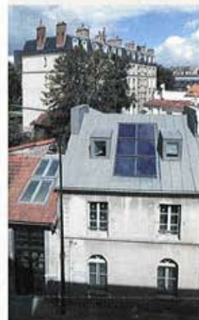
Façade Sud, sur rue, avant et après : architecture contextuelle préservée malgré la création de 2 lucarnes et la pose de 6 capteurs solaires Velux. Zinc prépatiné mat (VM Zinc) pour l'écologie et l'esprit toiture parisienne. © Paul Kozłowski
