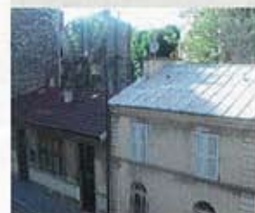
Façade Sud, sur rue, avant et après : architecture contextuelle préservée malgré la création de 2 lucarnes et la pose de 6 capteurs solaires Velux. Zinc prépatiné mat (VM Zinc) pour l'écologie et l'esprit toiture parisienne. © Paul Kozłowski
