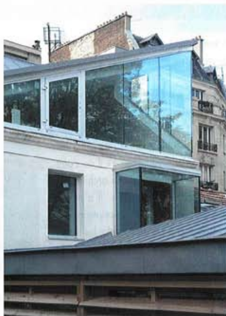
Vue sur la façade Nord au toit surélevé de 60 cm, avec un remarquable effet de plage. Clostura en métal pour protéger les baies vitrées du séjour à l'Est. © Paul Kozłowski
